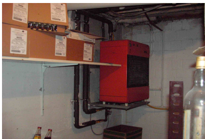
Bild: Wärmepumpe im Einsatz im Hotel Cafe Schoch.
